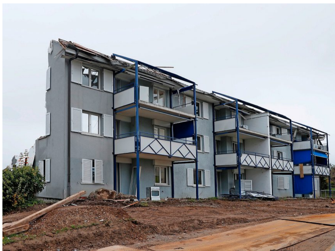
Vom einstigen Wohnhaus an der Riedthofstrasse steht nur noch die Fassade. Fotos: Sibylle Meier
