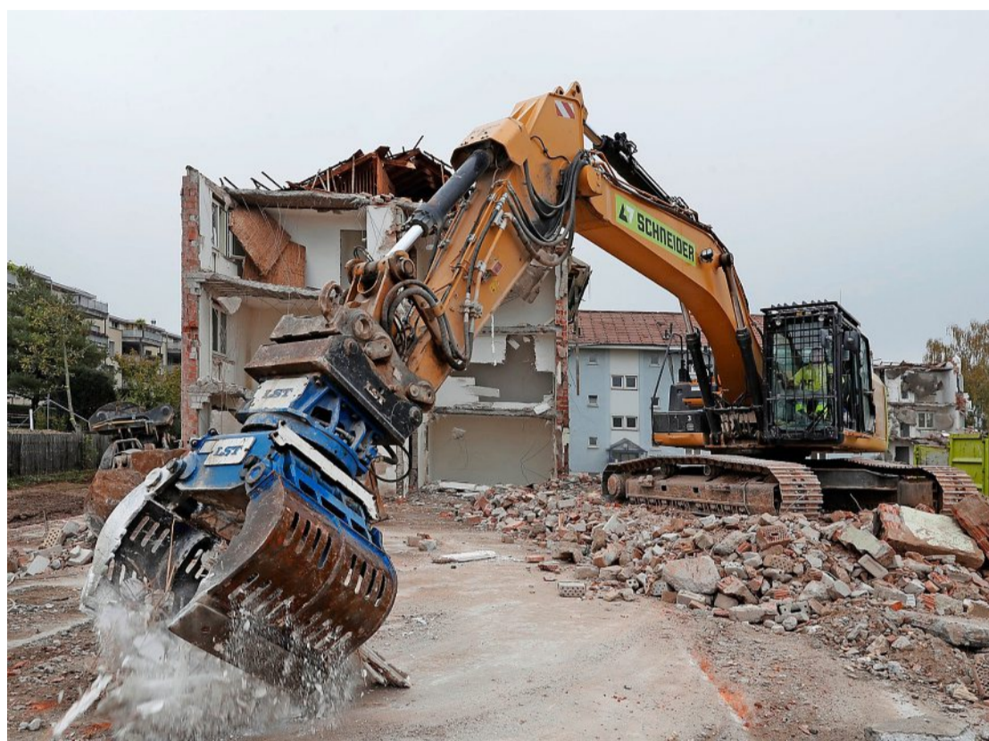
Der Abbruchbagger zerlegt die Häuser aus den 1950er-Jahren in Einzelteile.
